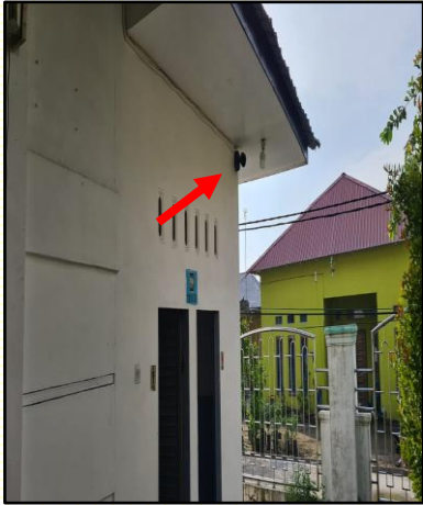
CCTV Luar Kantor
