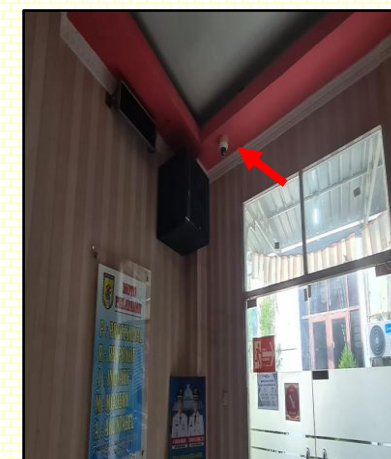
CCTV Dalam Kantor
